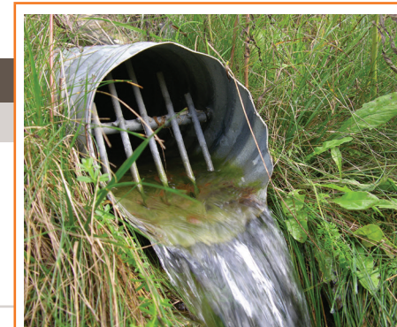
Comme les drains agricoles souterrains conduisent aux eaux de surface, les sites de compostage doivent en être éloignés d'au moins 10 m (33 pi).
