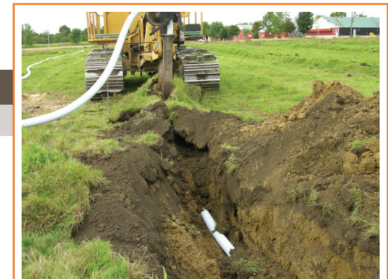
Pour réduire le risque que des contaminants pénètrent dans les drains agricoles souterrains et atteignent l'eau de surface, maintenez une distance de séparation adéquate – plus de 15 m (49 pi) – entre le conteneur d'élimination et les drains agricoles souterrains.
