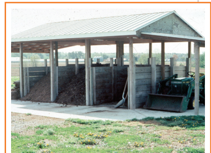
Un site de compostage recouvert d'un toit évitera que l'eau propre se mélange avec le compost et produise un ruissellement.
