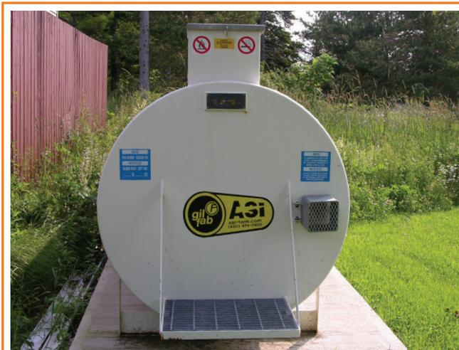
Évaluez l'état des réservoirs de stockage de combustible existants, et maintenez une protection contre la corrosion.
