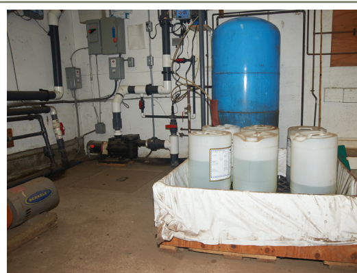
Les matières liquides exigent des précautions particulières, comme le recours à un dispositif de confinement secondaire.
