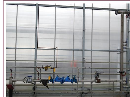
Chaque fois que l'équipement de fertirrigation est utilisé, vérifiez que les dispositifs antiretour sont en place et qu'ils fonctionnent afin d'éviter tout risque de contamination par refoulement du système d'approvisionnement en eau.
