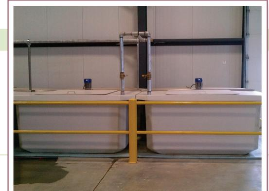
Placez les réservoirs dans un endroit isolé ou peu fréquenté, et à l'abri des chocs accidentels.
