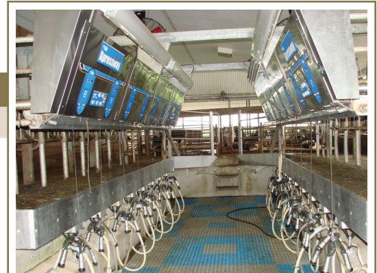
Avant de laver le plancher du centre de traite, évacuer les solides avec une pelle et un balai.
