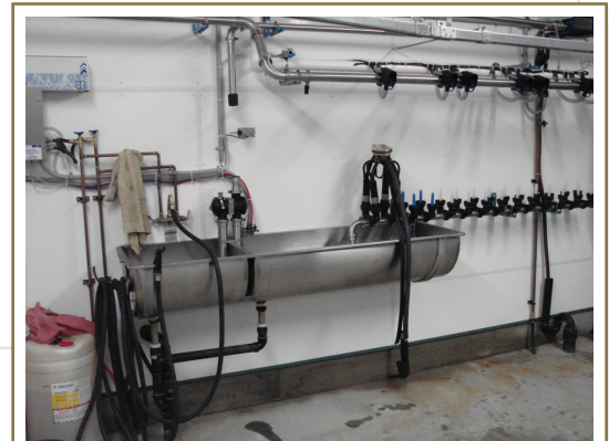
Un évier économiseur d'eau permet de réduire jusqu'à 45 % la quantité d'eau utilisée.
