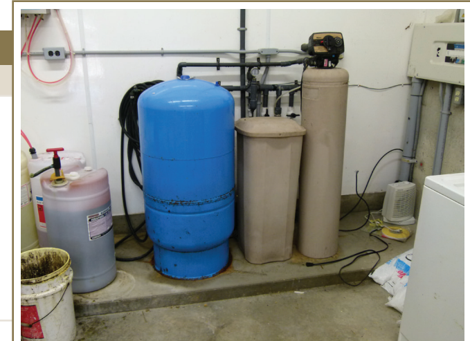
L'adoucisseur d'eau et les autres types de systèmes de traitement de l'eau doivent être inspectés et entretenus chaque année.
