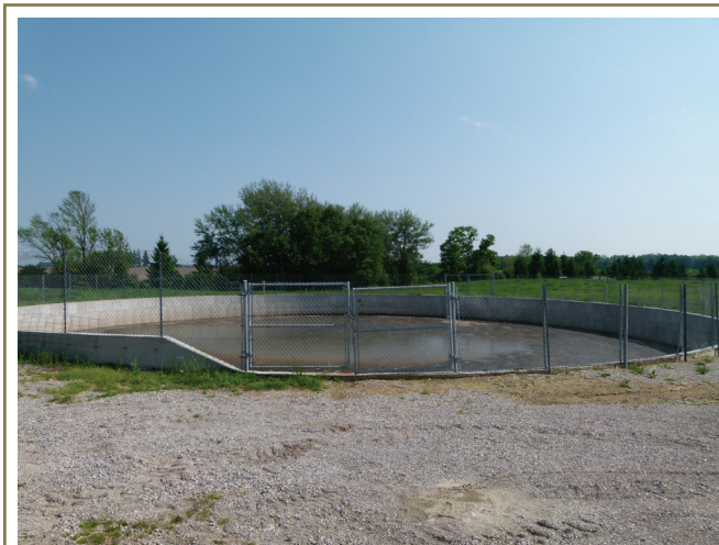
L'évacuation des eaux de lavage dans une structure d'entreposage de fumier liquide de capacité suffisante constitue une solution pratique.
