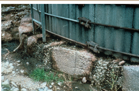
L'utilisation de matériaux appropriés et l'entretien du plancher du silo, des murs et des fondations peuvent minimiser l'écoulement des effluents. Il est également important que la structure des murs et des fondations soit solide pour la sécurité des travailleurs.
