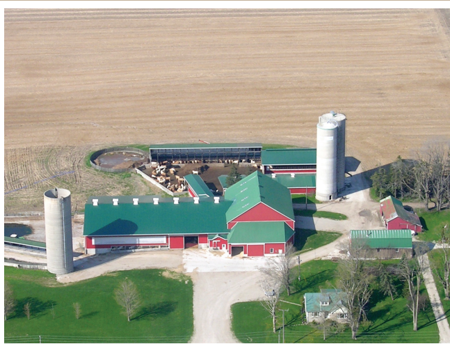
La réfection du revêtement des murs du silo contribue à empêcher l'écoulement des effluents et à maintenir le bon état de la structure du silo.
